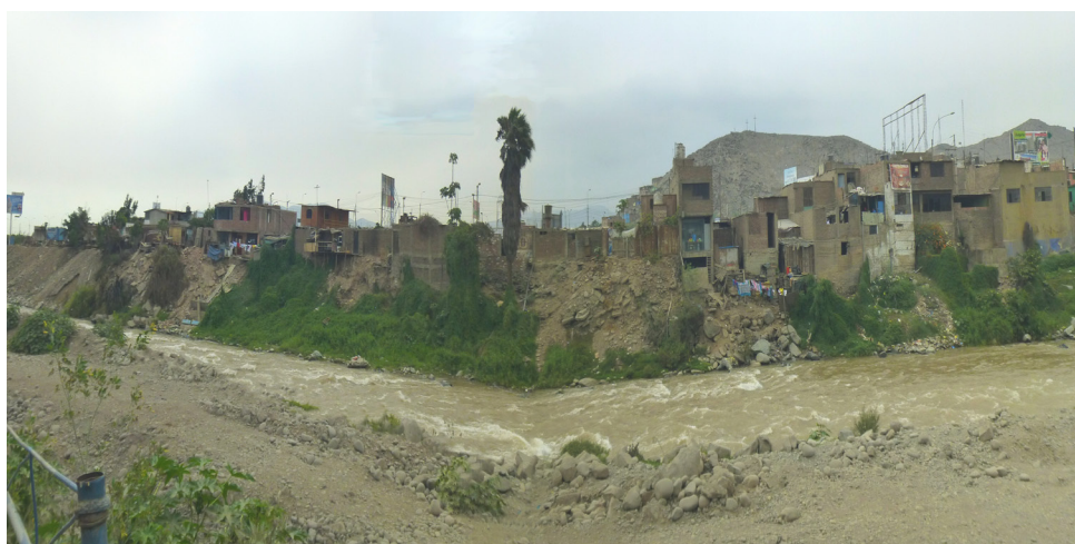
Figura 6. Viviendas en estado crítico construidas sobre terrazas del río Rímac a la altura de Huachipa (Chosica-Ate). Figure 6. Housing in critical condition built on alluvial terraces of the Rímac river at Huachipa (Chosica-Ate).
