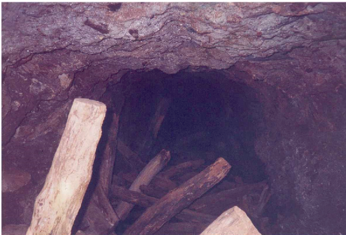
Figura 4. Boca mina de Farallón Blanco sobre la margen derecha del río El Naranjito. Se puede apreciar el estado precario del túnel, con el enmaderado colapsado (Tomado de Falcón, 2004). / Figure 4. Farallón Blanco mine mouth on the right bank of the El Naranjito river. You can see the precarious state of the tunnel, with the collapsed timber. (Taken from Falcón, 2004).
